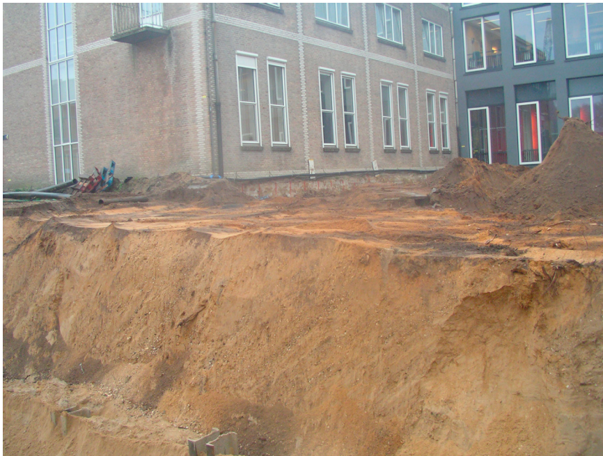
Figuur 7. Werkput 17 naast de zuidelijke vleugel van de St. Maartenskliniek. JW
